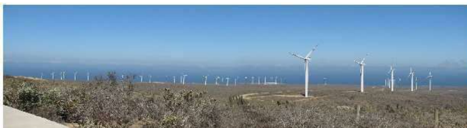
Parque eólico Canelo 1 y 2. Coquimbo (IV Región)
