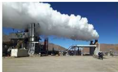
Cerro Pabellón es la primera central geotérmica en Chile
