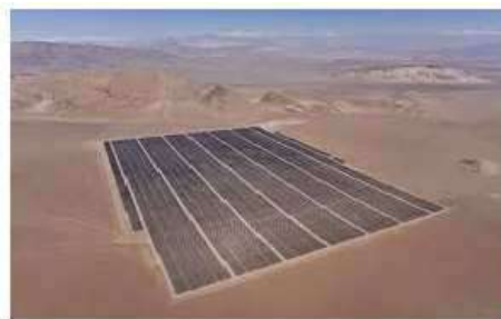
Paneles Fotovoltaico Norte Grande
