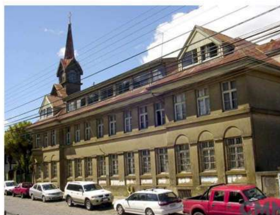
Iglesia San Francisco de Valdivia
