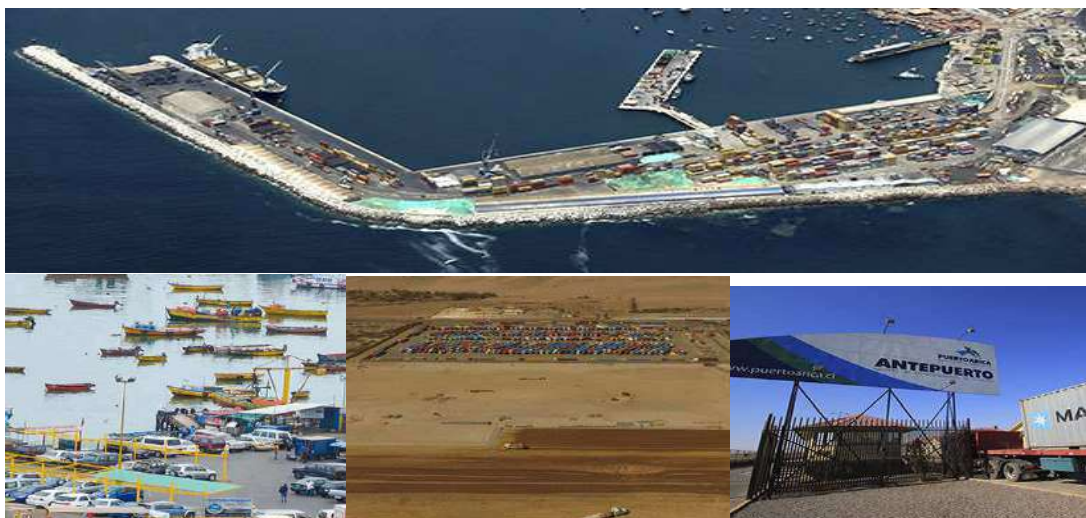
Sectores del Puerto de Arica
