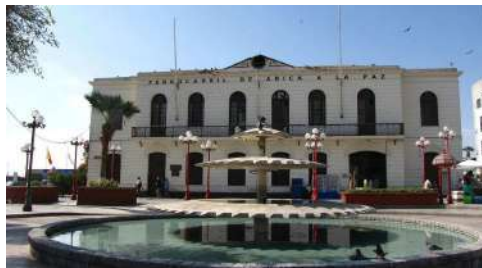
Estación de Ferrocarril Arica-La Paz
